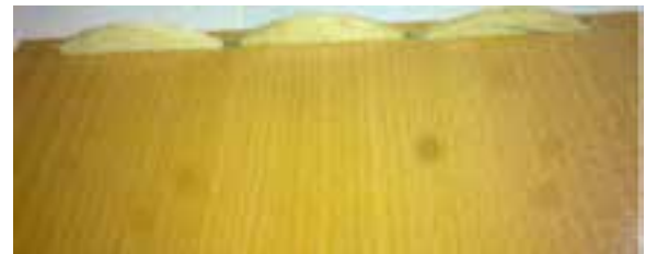
شکل ۲-۱۷- اتصال بیسکویتی سر به سر.
